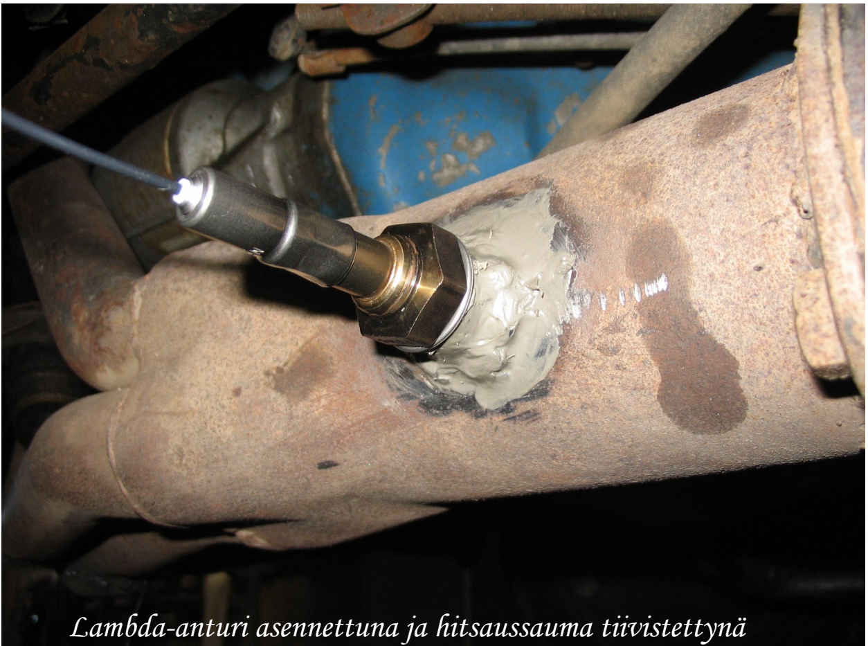
Hitsaussauman tiivistys, mikäli et usko sen olevan ilmatiivis
